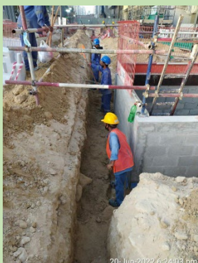
DI Pipe Excavation
