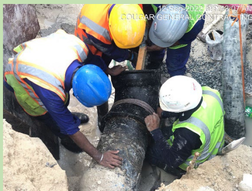
DI 300 Pipe Shutdown work
